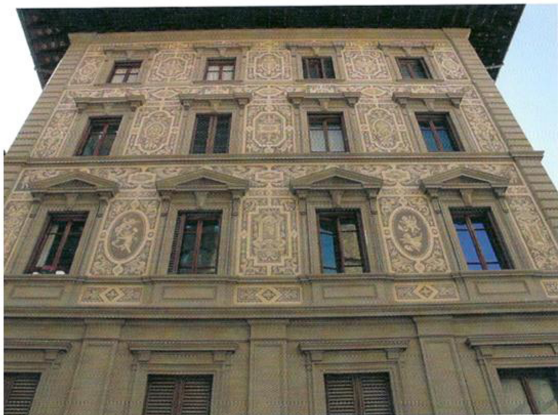
Palazzo della Società Cattolica delle Assicurazioni (1892), via Calimala 2
