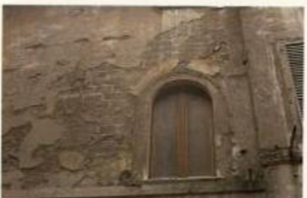
e) ROMA, EDIFICIO IN VIA DEI CAPPELLARI, 61-62 PARTICOLARE DELLA FACCIATA
