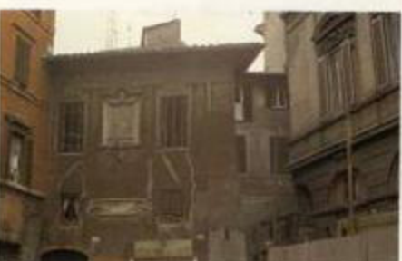
f) ROMA, EDIFICIO IN PIAZZA DEL BISCIONE, 90 FACCIATA
