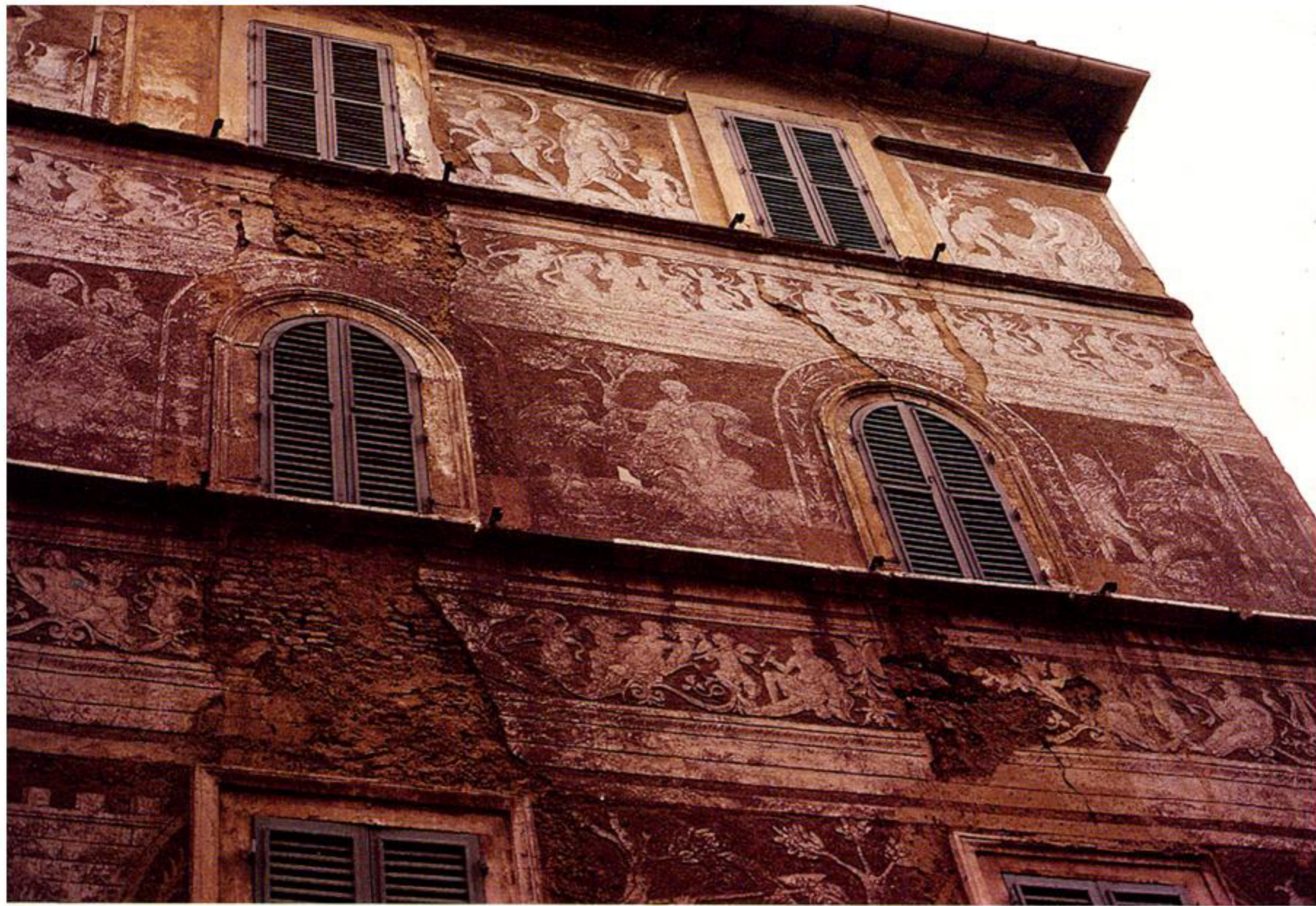
Roma, edificio in via della Maschera d'Oro – esempio di intonaco decorato a graffito attribuito a Baldassarre Peruzzi. Per questi rivestimenti viene usata una colla di carbone, impasto costituito da una parte di calce colata fine, due parti di sabbia o pozzolana e carbone di legna polverizzato al mortaio . Questa colla veniva applicata dai muratori sulle facciate degli edifici decorati a sgraffito dai pittori che intervenivano successivamente.
