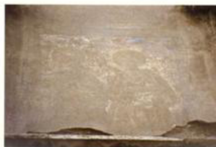
a) ROMA, EDIFICIO IN VIA DEI GIUBBONARI, 46-47 RIQUADRO DEL SECONDO LIVELLO RAFFIGURANTE FIGURE DI SANTI
