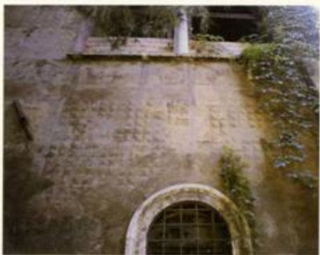
d) ROMA, CASA DEL CURATO IN VIA JACOVACCI LATO DESTRO DEL PROSPETTO OVEST
