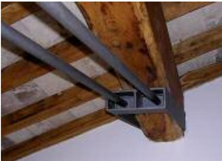
4.51 Particolare costruttivo ed esecutivo del nodo d'appoggio e sistema d'ancoraggio del tirante doppio.
