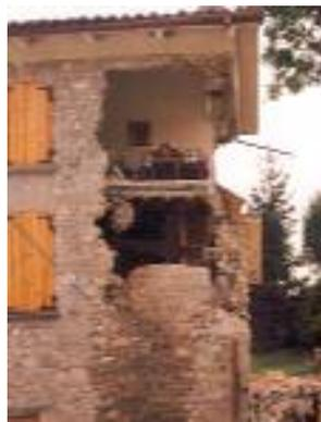
4.18 La foto evidenzia una risposta sismica anomala in presenza di solai rigidi – (Ing. A. Anastasi) Terremoto in Umbria-Marche 1997.
