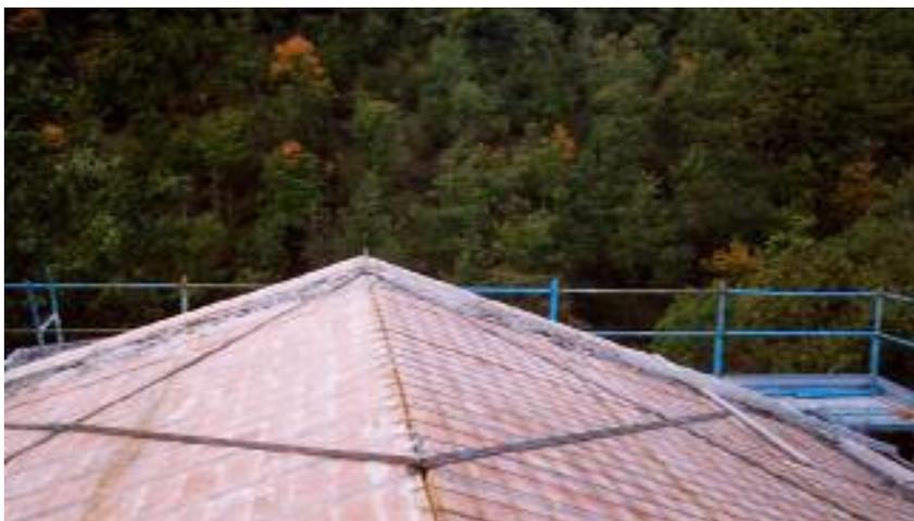
L'assenza di pareti trasversali di controvento nell'ampia navata della chiesa espone la maglia muraria al rischio di deformazioni planimetriche molto pericolose, per cui è necessario irrigidire le falde mediante dei controventi metallici ancorati sul vertice delle capriate e sulle armature dei cordoli perimetrali.
