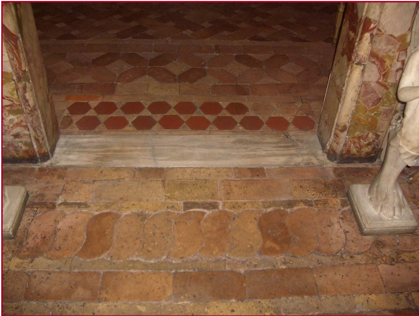
Roma, Palazzo Spada, dettaglio delle fasce di ammattonato al piano nobile
