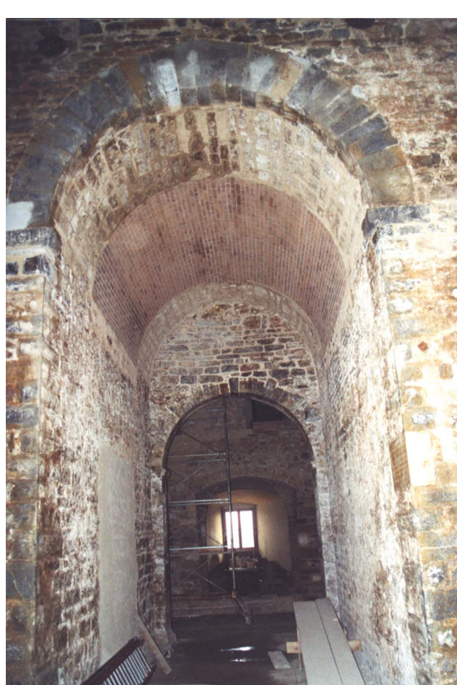
La porta della torre riaperta e la volta in pietra parzialmente ricostruita in mattoni. Sopra: un momento della rimozione del tamponamento
