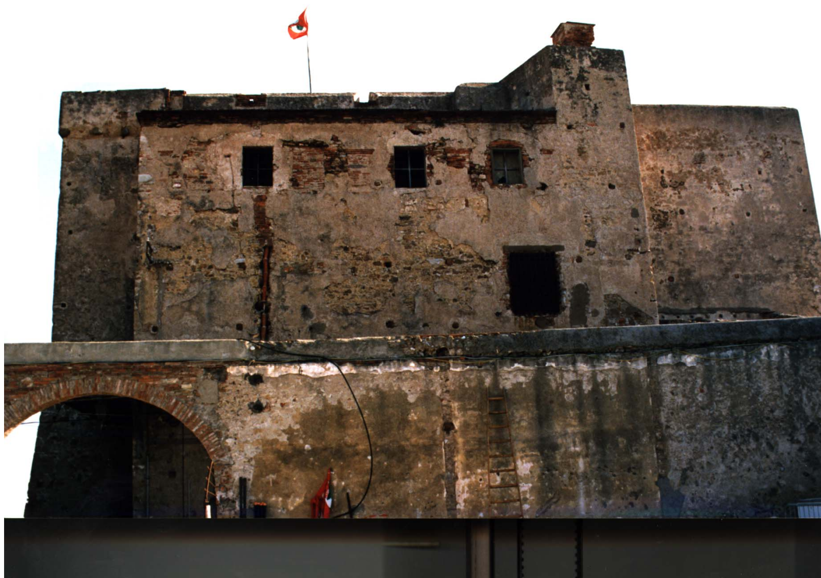
Il fronte nord prima del restauro
