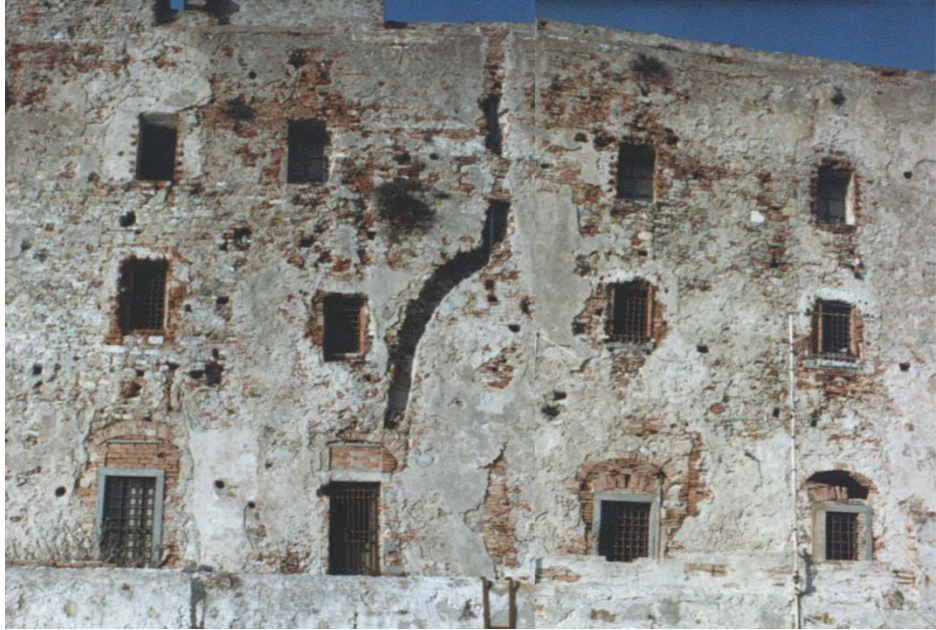
Prospetto sud prima del restauro
