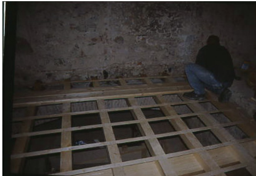
Ricostruzione dei solai lignei
