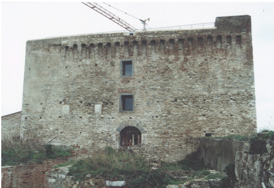
Prospetto ovest dopo il restauro
