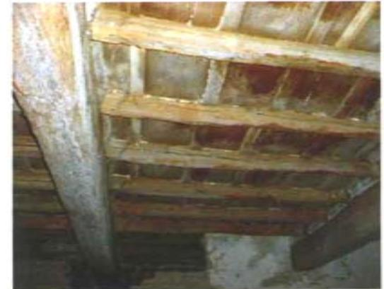
3., 7., 8. Le immagini mostrano le due orditure portanti che costituiscono il solaio, l'andamento dei regoli per convento, disposti superiormente, e l'appoggio dei travicelli in cui si notano ancora gli incassi delle bussolle, originariamente presenti e poi rimosse
