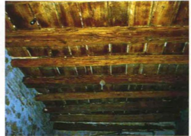
3., 6., 7. Le immagini evidenziano l'orditura di travicelloni del solaio preesistente e quella dei travicelli aggiunti in mezzera nel corso d'un successivo intervento di consolidamento
