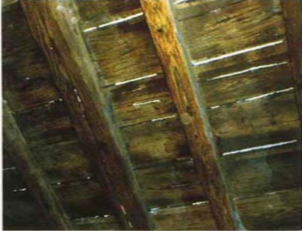
Questo semplice solaio rustico da mezzanino è costituito da un'orditura realizzata con travicelloni sommariamente riquadrati di varie dimensioni, posti ad un interasse piuttosto ampio; un tavolato rustico con elementi di larghezze diverse; un massetto poco coeso e leggero; l'allettamento e il mattonato. Le travature intermedie sono state successivamente inserite nelle rispettive mezzerie, fra le travi originali.
