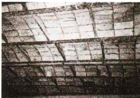
9. Solaio a voltine di mattoni con elementi metallici di irrigidimento trasversale (Roma, fine XIX sec.)
