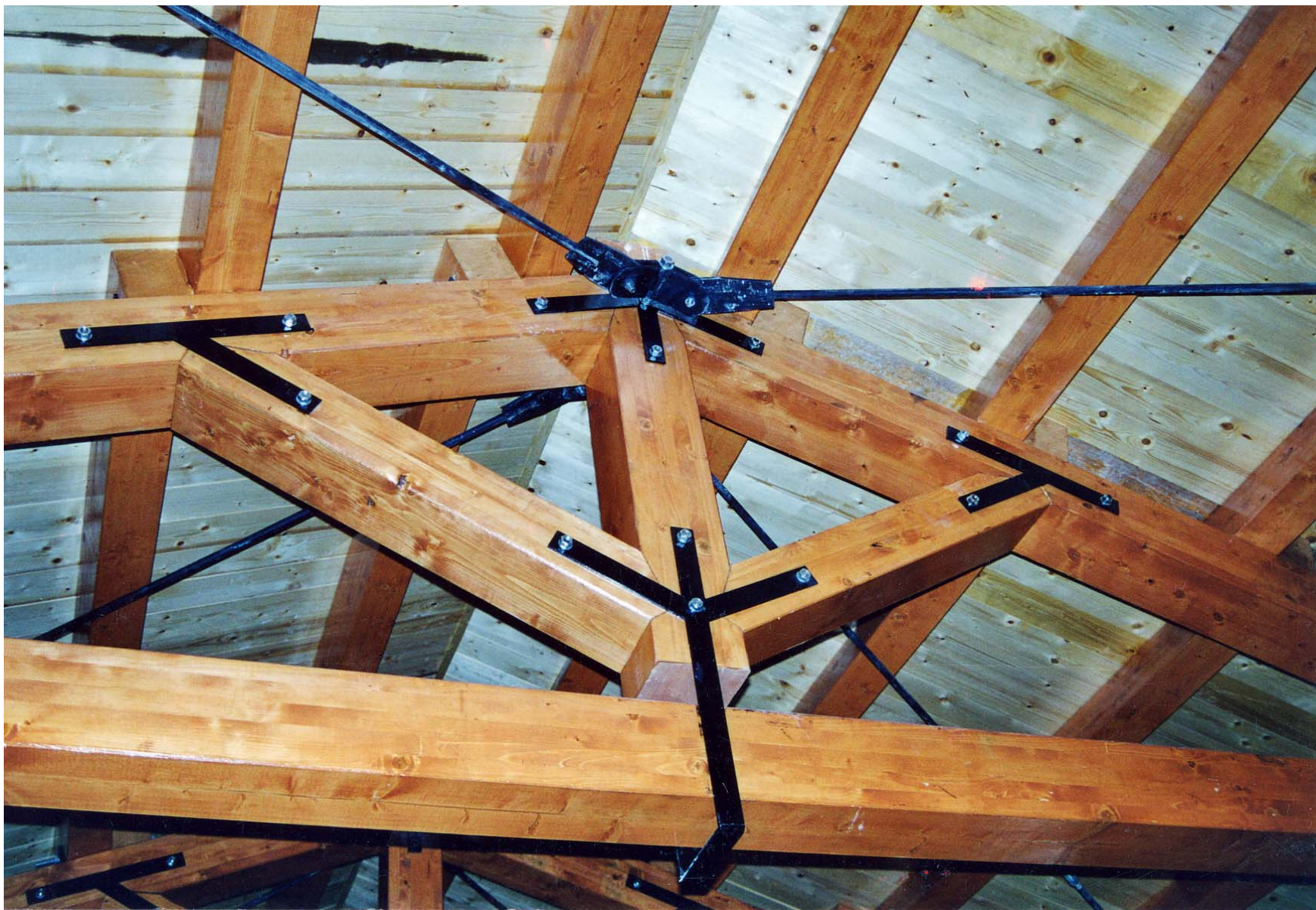
La stessa copertura realizzata
