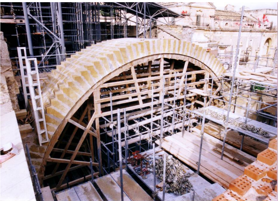
L'apparecchio lapideo e l'orditura della volta di finitura in "camera canna". Foto Tringali- De Benedictis
