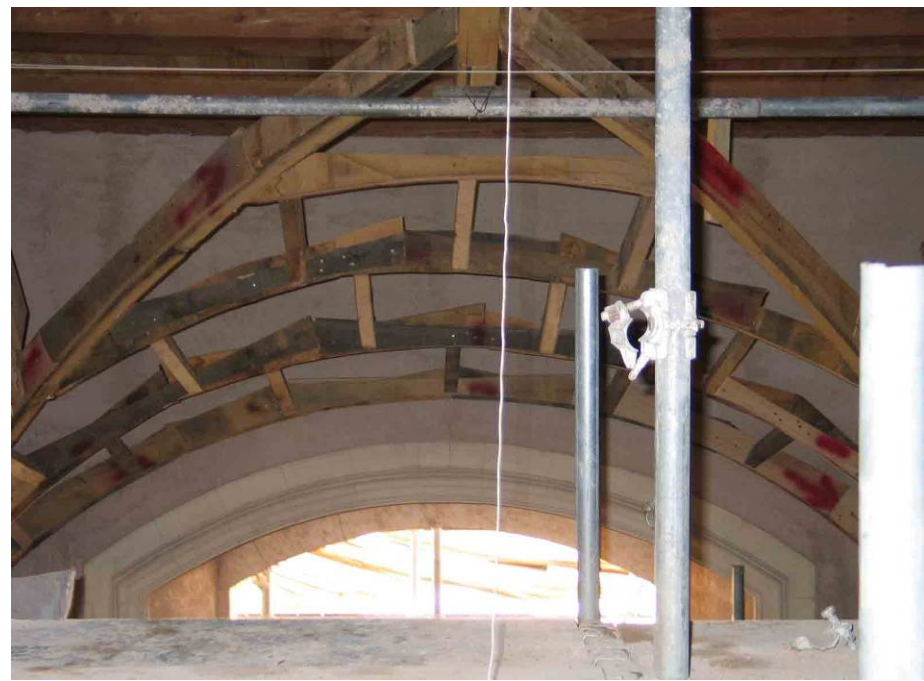
L'apparecchio lapideo e l'orditura della volta di finitura in "camera canna". Foto Tringali- De Benedictis
