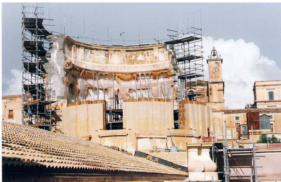
Il tamburo della Cattedrale di Noto durante le fasi della ricostruzione.
