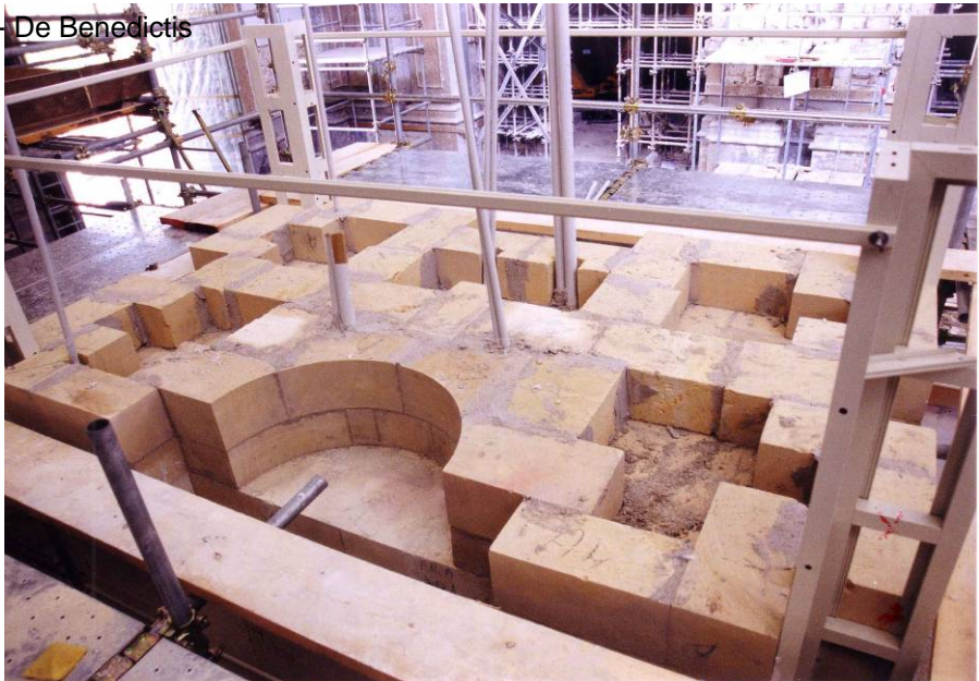
In alto a sinistra, gli elaborati grafici del progetto di ricostruzione dei pilastri della cattedrale. Le foto illustrano le diverse fasi di ricostruzione dei pilastri.
