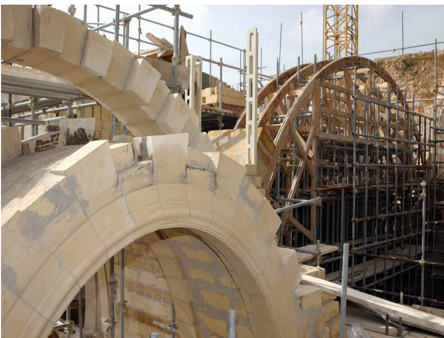
La ricostruzione degli archi e della volta della navata centrale e laterale. L'apparecchio lapideo viene realizzato in pietra locale su centine lignee. Foto Tringali- De Benedictis
