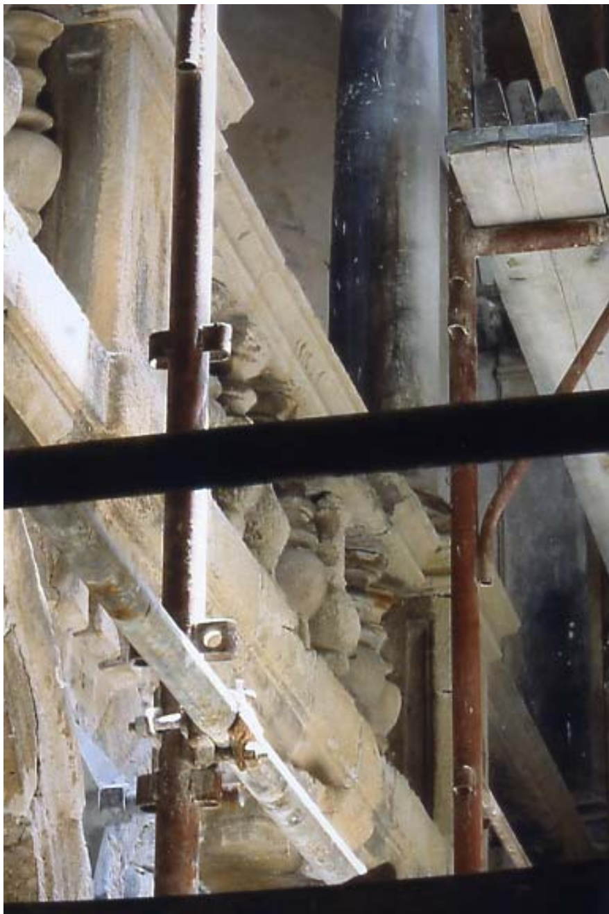
Trapani, il Palazzo Riccio di San Gioacchino. I balaustri degradati e corrosi
