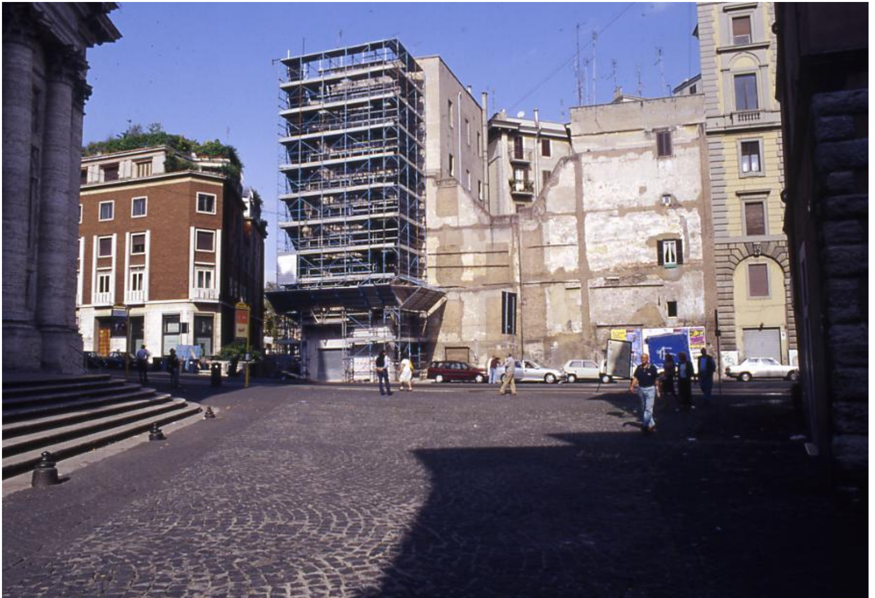
Demolizioni umbertine in Piazza dell'Oro a Via Giulia
