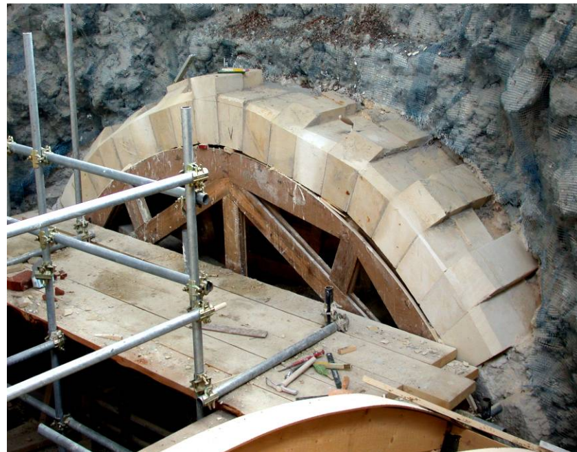
La ricostruzione degli archi e della volta della navata centrale e laterale. L'apparecchio lapideo viene realizzato in pietra locale su centine lignee. Foto Tringali- De Benedictis
