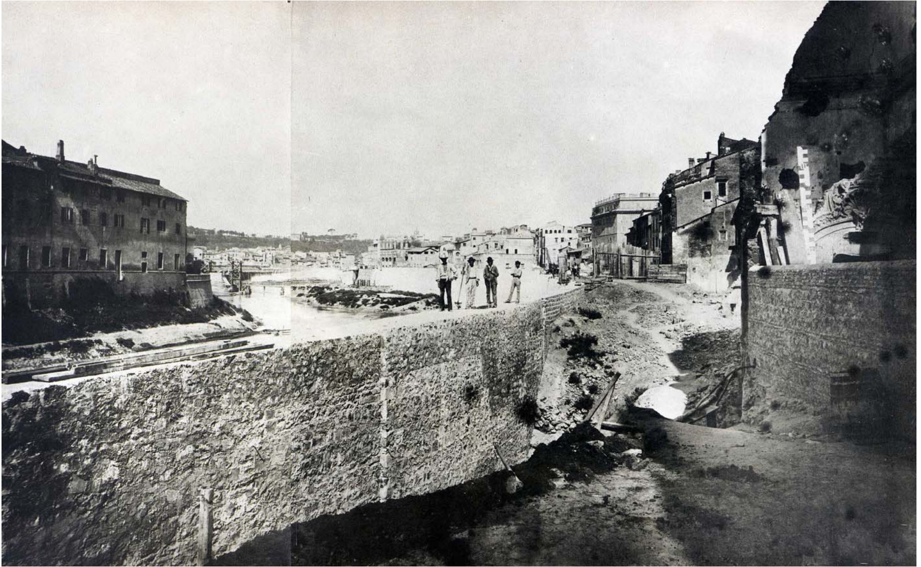
In primo piano ossatura muraglioni, masselli di tufo e pietra locale
