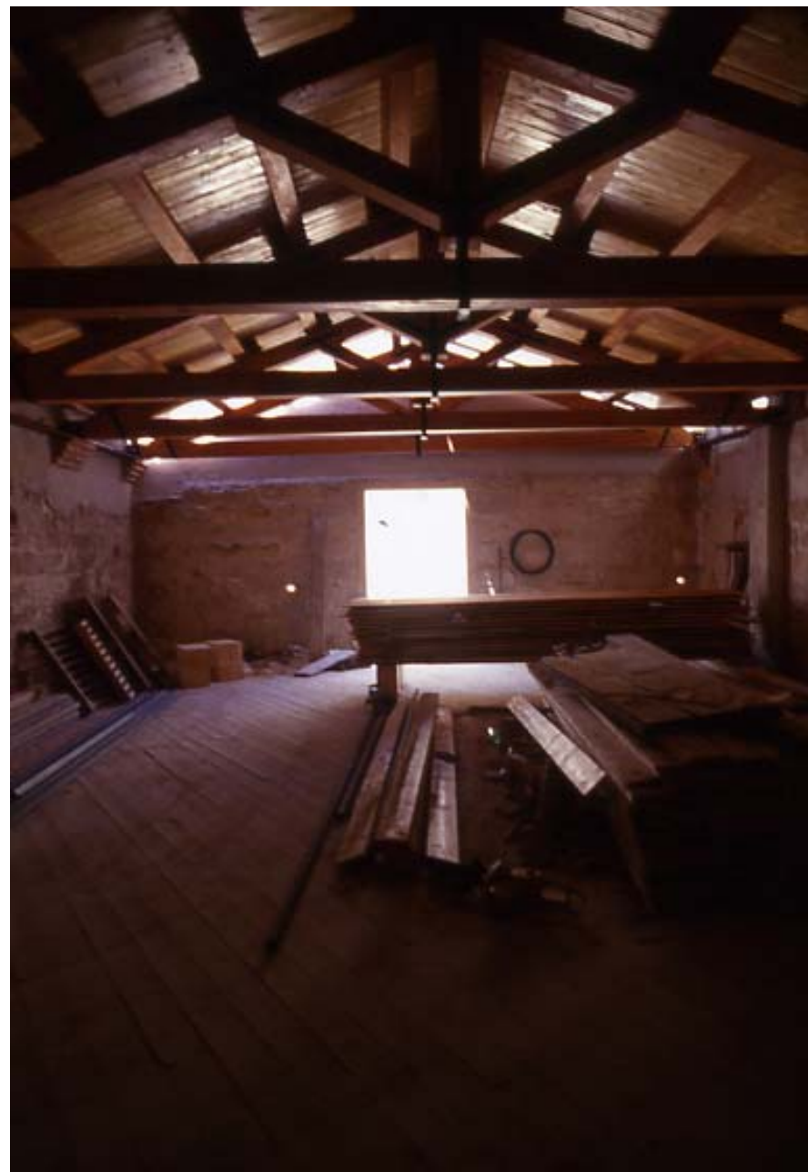
Trapani, il Palazzo Riccio di San Gioacchino. Cantonale di sinistra restaurato e tetti nuovi in legno lamellare
