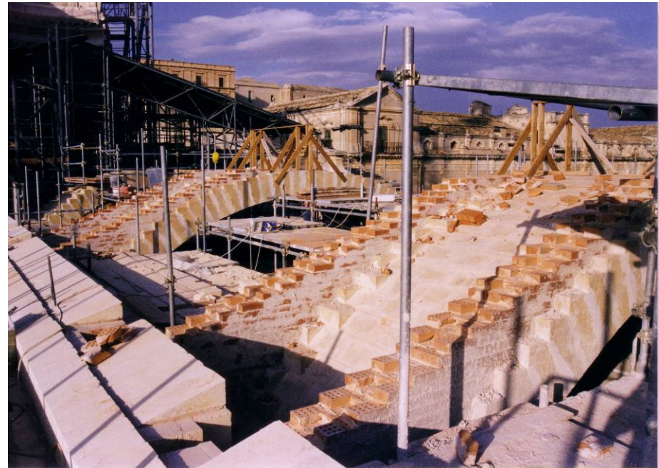
L'apparecchio lapideo e l'orditura della volta di finitura in "camera canna". Foto Tringali- De Benedictis
