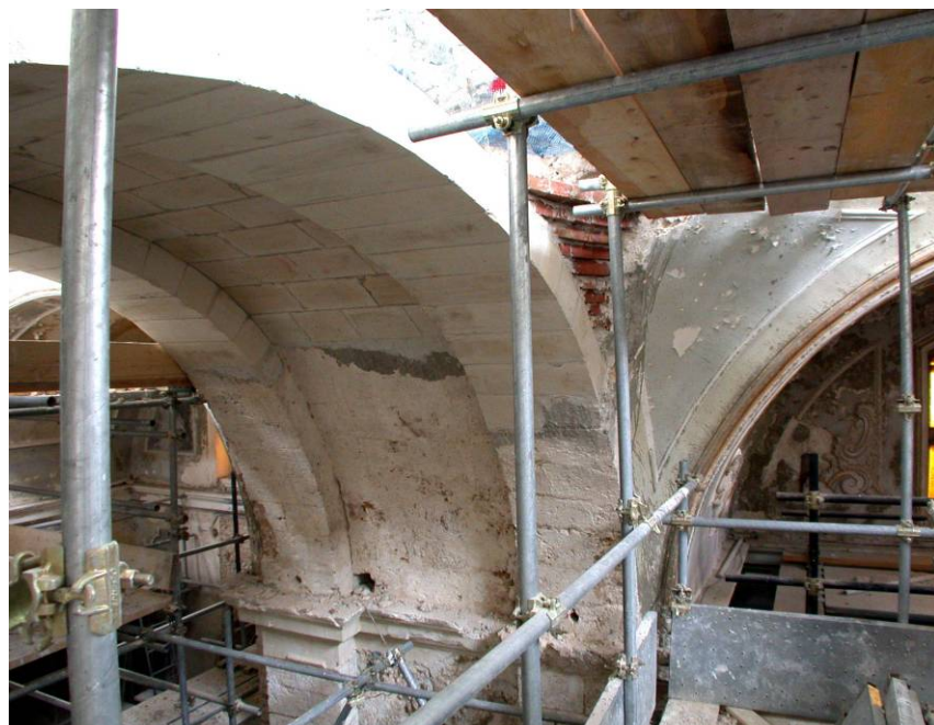
La ricostruzione degli archi e della volta della navata centrale e laterale. L'apparecchio lapideo viene realizzato in pietra locale su centine lignee. Foto Tringali- De Benedictis
