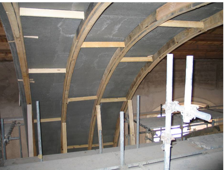
L'apparecchio lapideo e l'orditura della volta di finitura in "camera canna". Foto Tringali- De Benedictis
