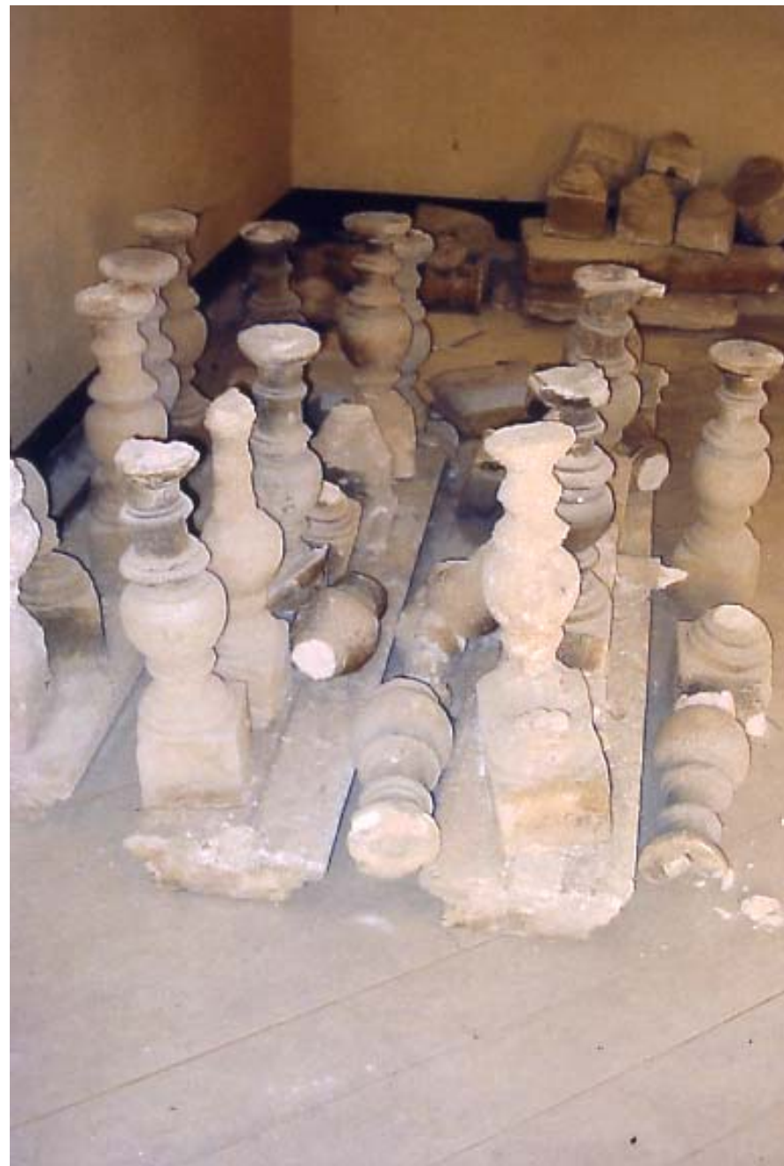
Trapani, il Palazzo Riccio di San Gioacchino. I balaustri degradati e corrosi
