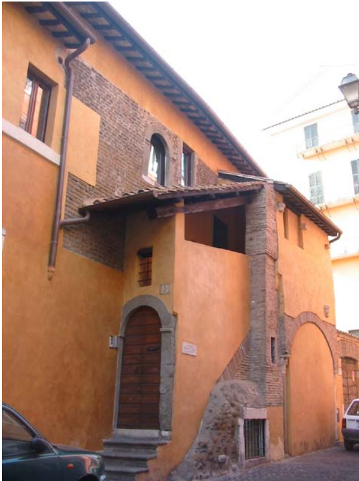
Casa con “profferlo” tamponato in vicolo della luce
