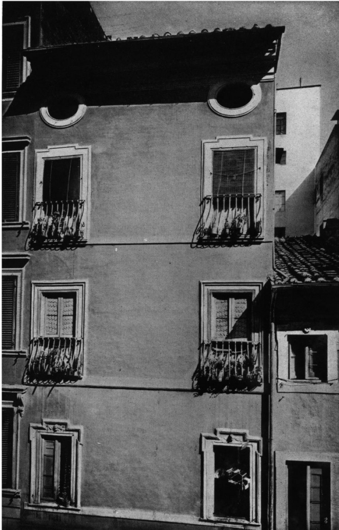
Casetta in via Urbana.
