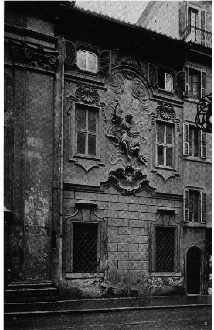
Canonica della Chiesa dei SS. Angeli Custodi al Tritone (sotto demolizione).
