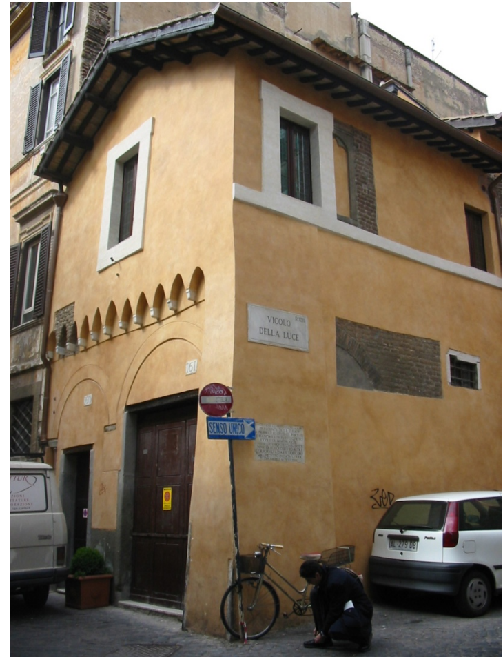
Casa con portico in via della Lungaretta
