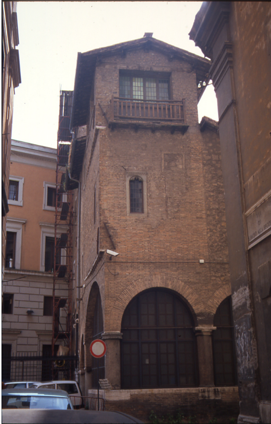
Casa medievale a S. Paolo alla Regola restaurata e parzialmente rcostruita da C. Bazzani negli anni 30 del Novecento
